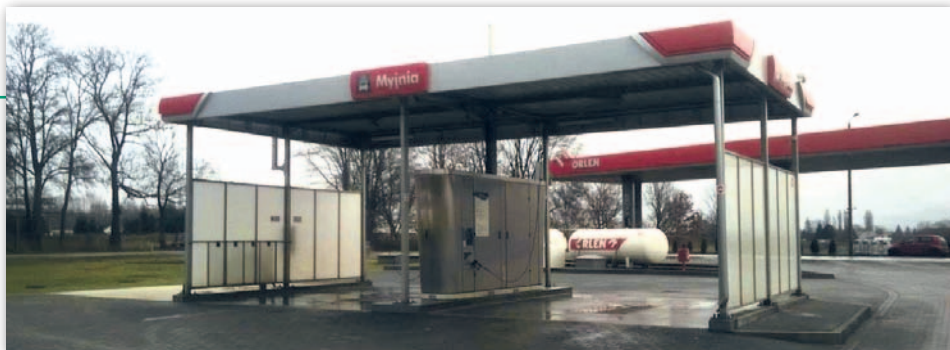
Rys. 1. Wiaty myjni samochodowej zlokalizowanej na terenie stacji paliw
