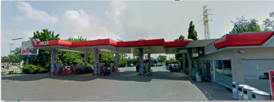
Rys. 4. Wiata nad dystrybutorami stacji paliw. Obok budynek sklepu i obsługi stacji paliw
