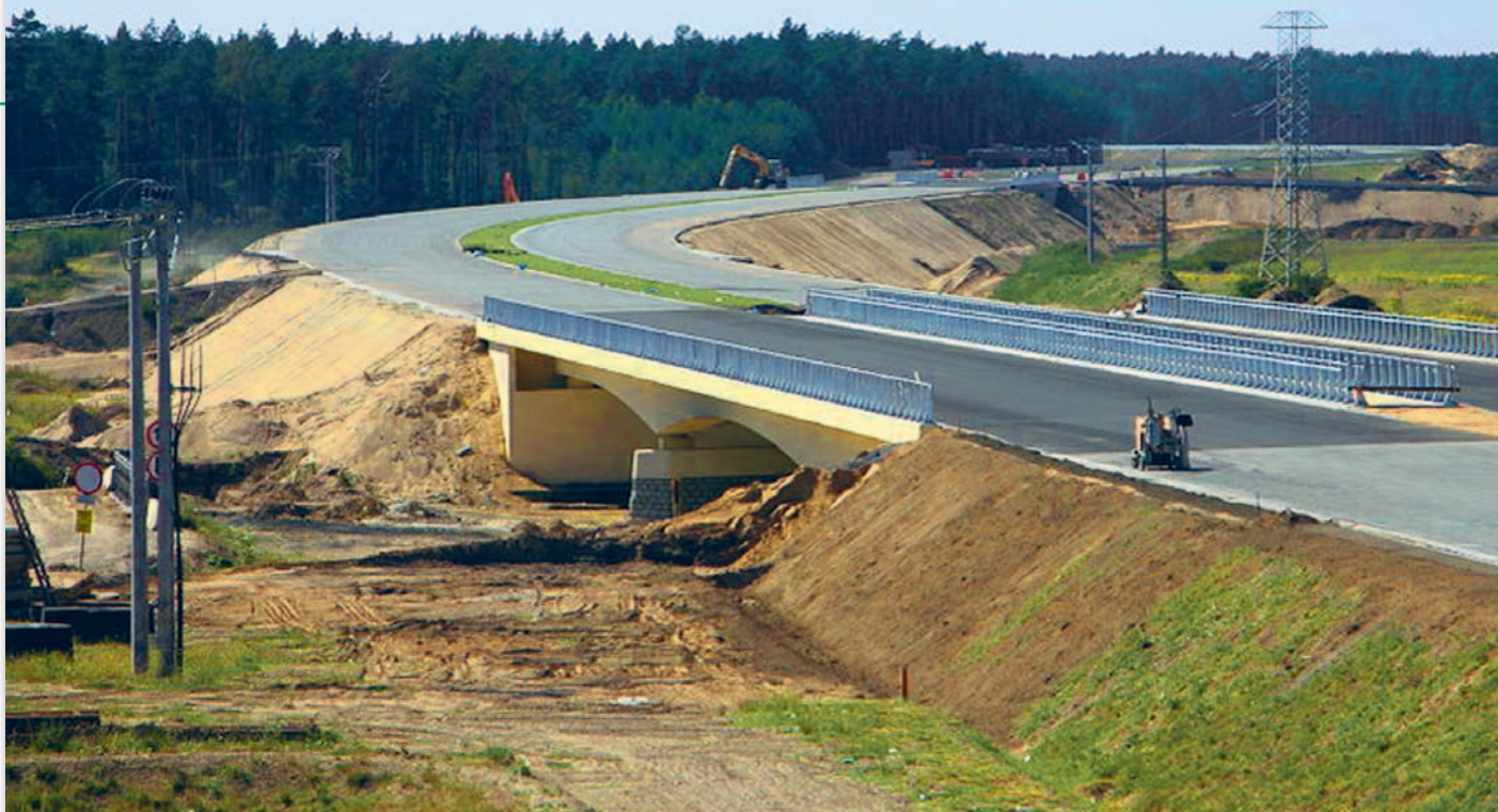
1. Budowa węzła w miejscowości Krzyżowa koło Bolesławca ze zjazdem na nowy odcinek w kierunku Zgorzelca (lata 2000-2006)
