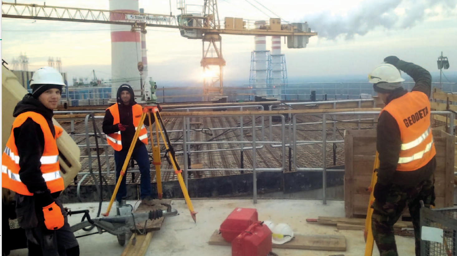
Załoga Geo-Mapy na dachu zbiorników retencyjnych popiołu podczas tyczenia kotew i marek
