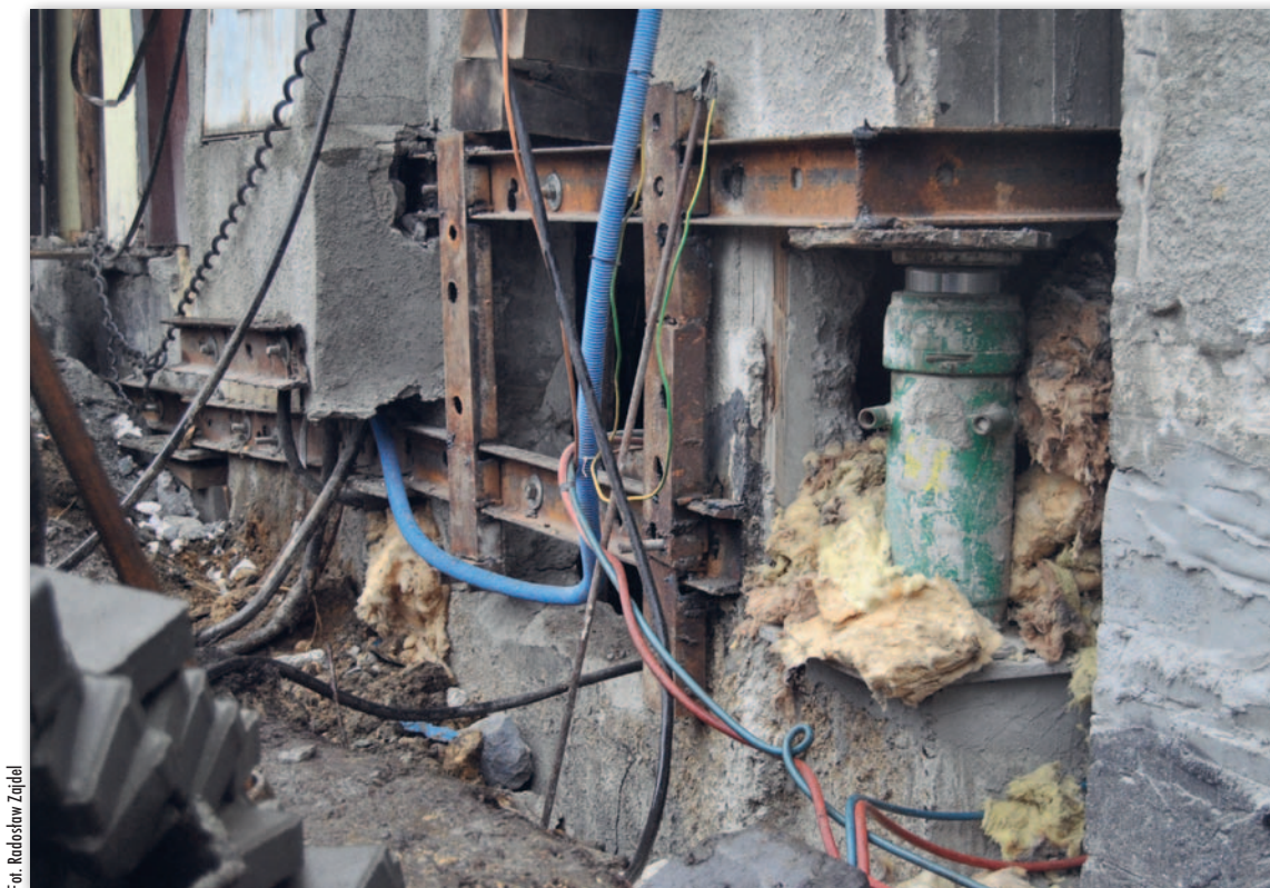
Rys. 1. Obiekt w Piekarach Śląskich – jeden z podnośników hydraulicznych i fundamenty wzmocnione profilami stalowymi
