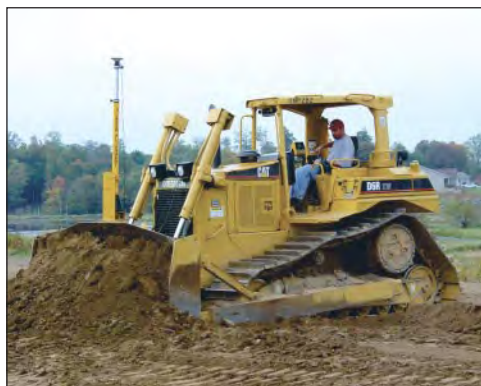
System GPS Leica zamontowany na spychaczu
