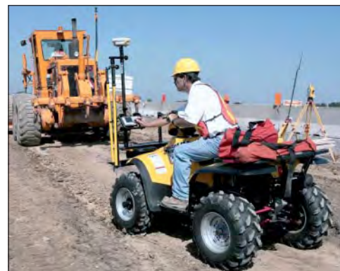
Kontrola prac ziemnych (Trimble)
