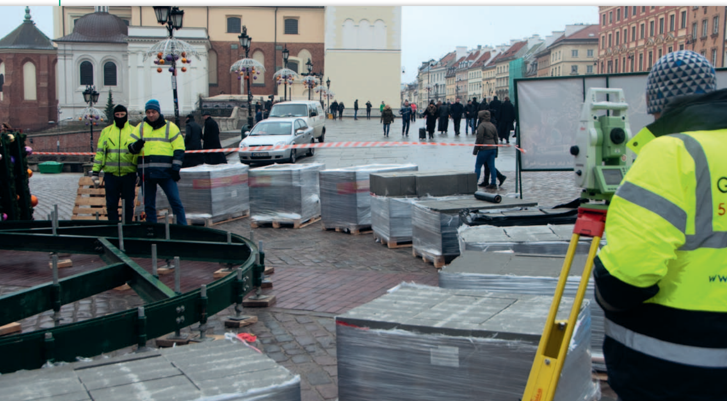
Geodeci z firm C-Geo i Hapi w trakcie pomiaru podestu
