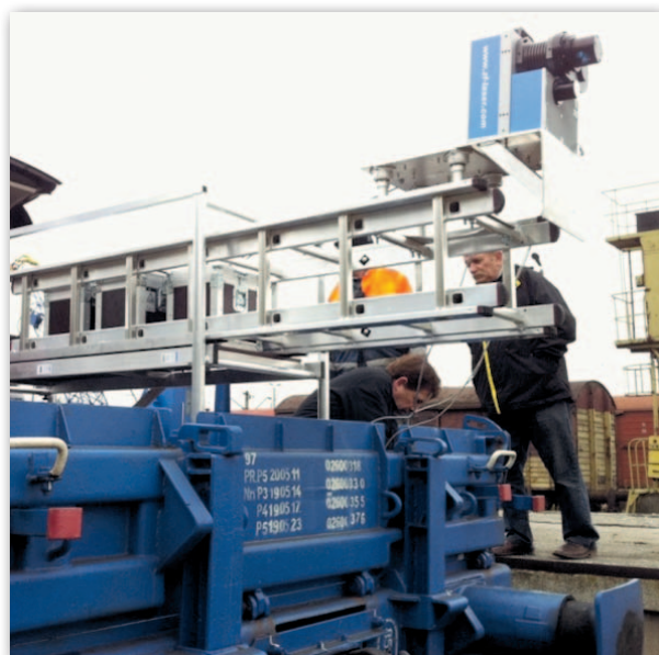
Rys. 1. System I – skaner Z+F Profiler 9000 podczas montażu na wagonie kolejowym
