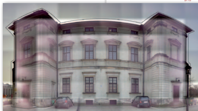
Rys. 2. Zakres skanowania elewacji północnej ze stanowiska 6
