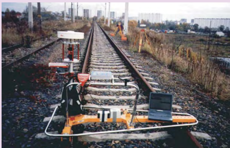
Rys. 2. Wózek pomiarowy zaopatrzony w krótką kolumnę do umieszczenia głowicy pomiarowej. W tle stacja referencyjna GPS oraz precyzyjny tachimetr elektroniczny
