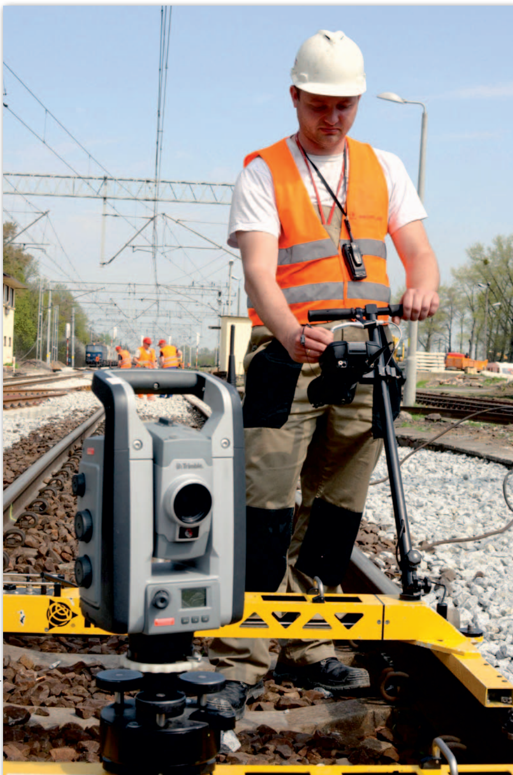
Pomiar torów za pomocą systemu Trimble GEDO podczas modernizacji linii nr 1 na odcinku Kuluszki – Częstochowa
