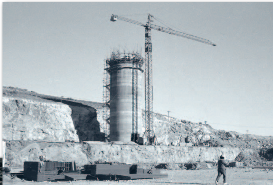
Na budowie zakładu wzbogacania rudy żelaza. Gotowy pierwszy silos na tarasie „wyciętym” w skale, Patagonia, rok 1974
