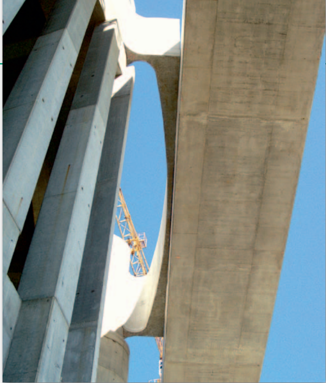
Po osadzeniu w trzeciej płaszczyźnie. Zdjęcie wykonane z ziemi spod wciągniętego mostu pokazuje, w jak małą przestrzeń się zmieścić
