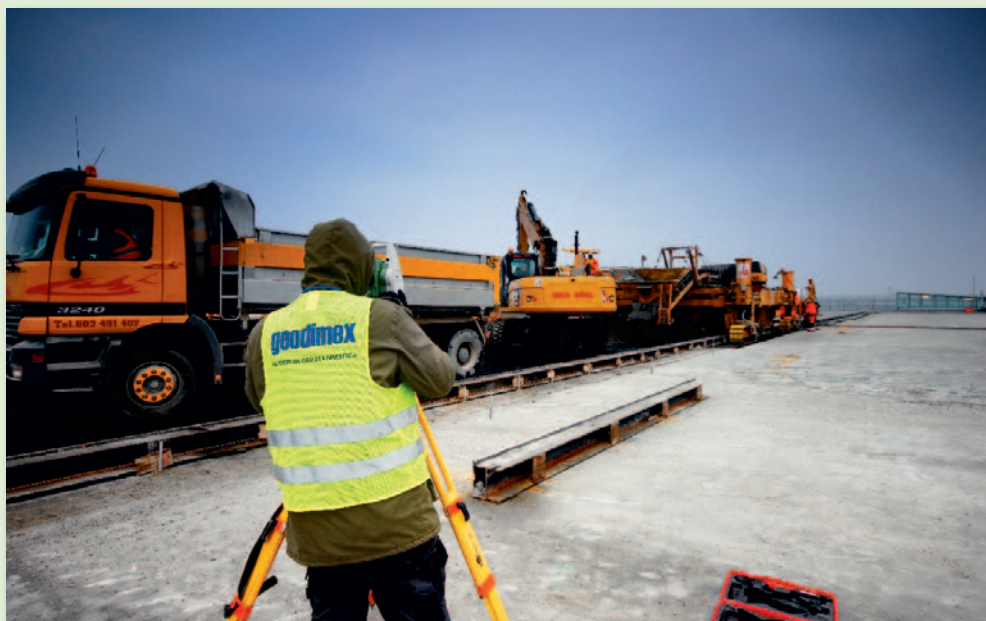
Bieżąca kontrola pracy rozścielacza do betonu (zdjęcie z realizacji)
