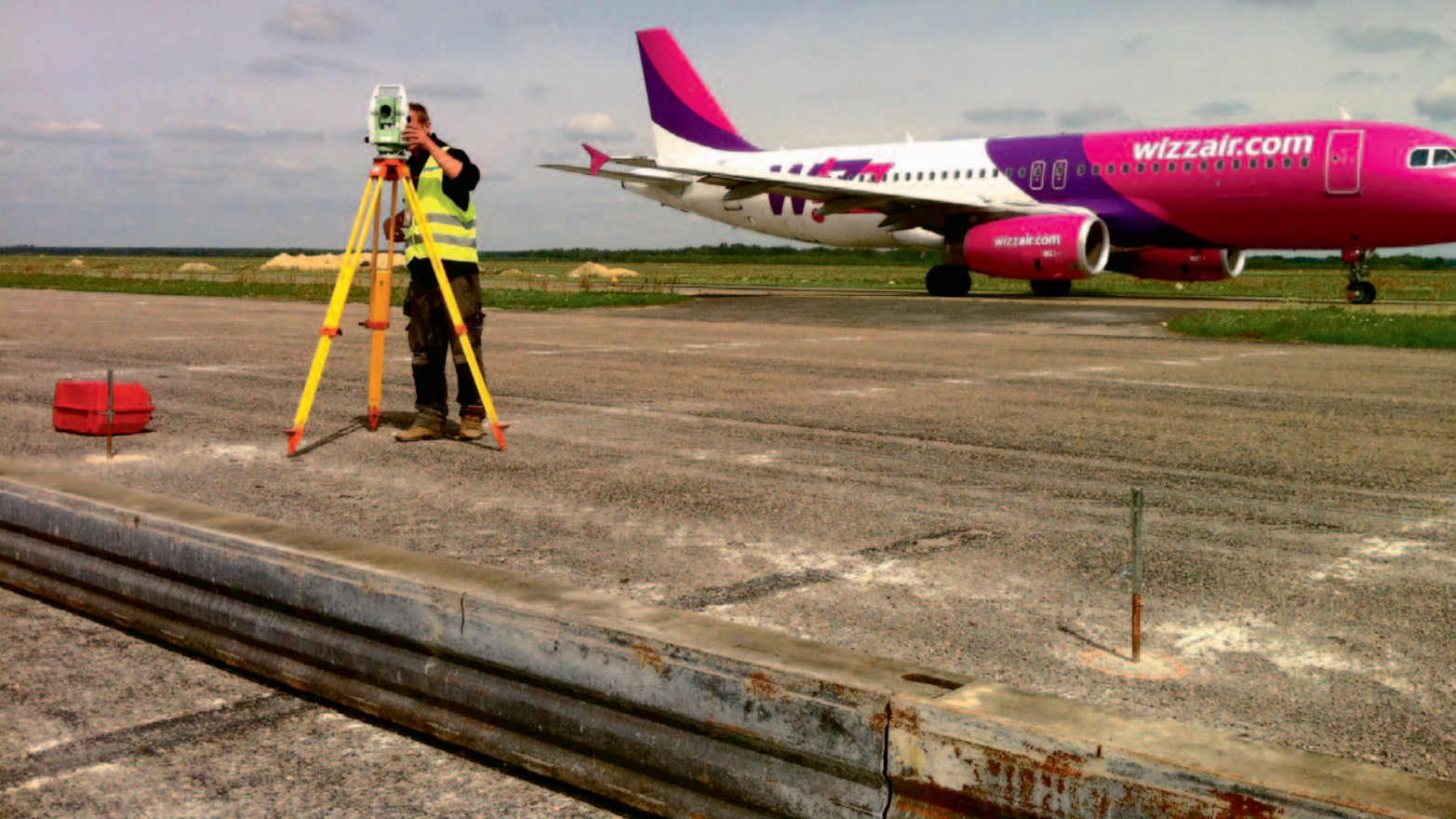
Sprawdzenie ustawienia szalunków pod beton nawierzchniowy (zdjęcie z realizacji)
