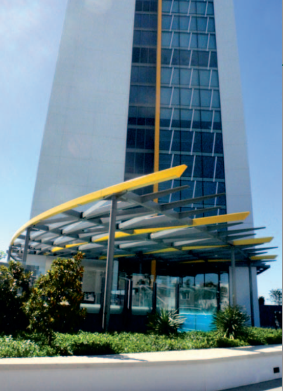
Apartamentowiec, w którym mieszka Krzysztof Kubicki. Przed wejściem basen-akwarium
