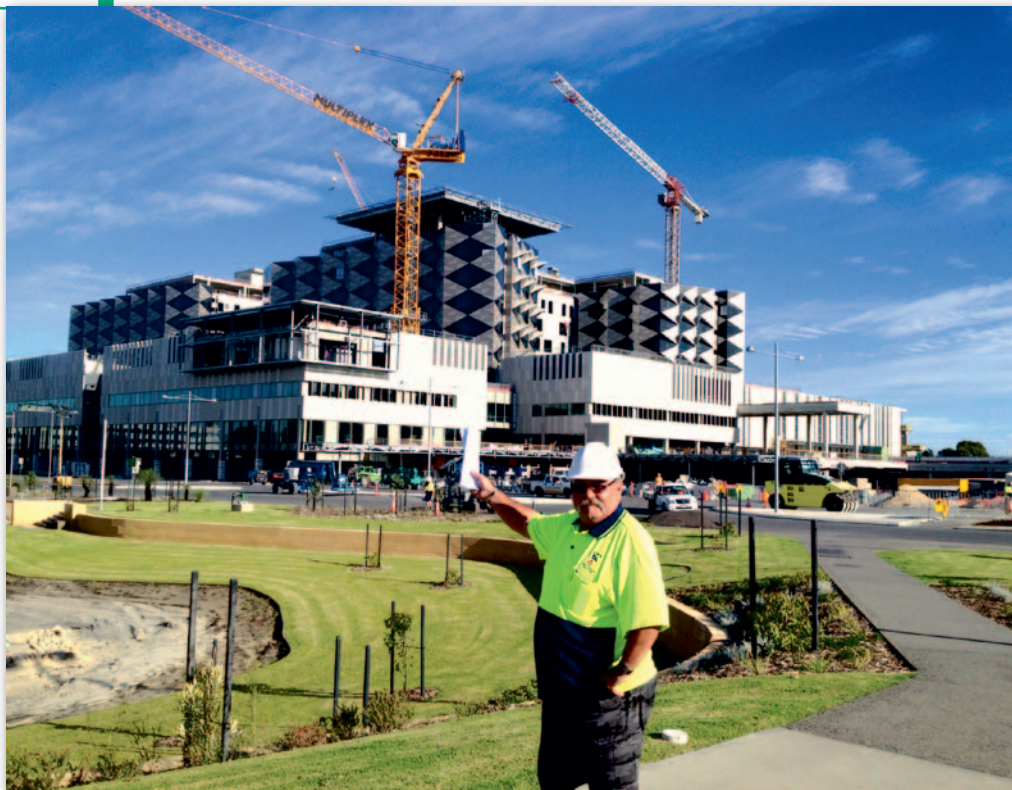
Krzysztof Kubicki na budowie Fiona Stanley Hospital, Perth, marzec 2012 r.
