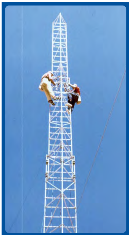
Montaż 25-metrowej wieży
