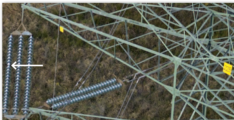
Zlokalizowane uszkodzenie izolatora (pierwszy od lewej) i widoczne oznakowanie słupa
