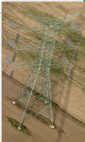
Słup mocny linii najwyższych napięć 400 kV i chmura punktów ze skaningu laserowego
