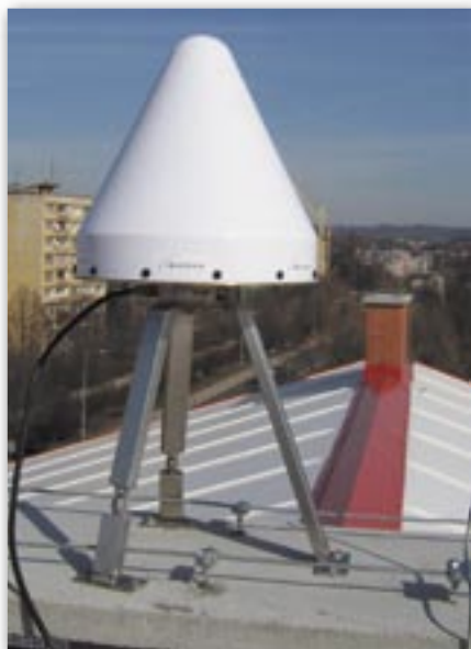
3. Montaż anteny GPS przy użyciu uniwersalnego statywu
