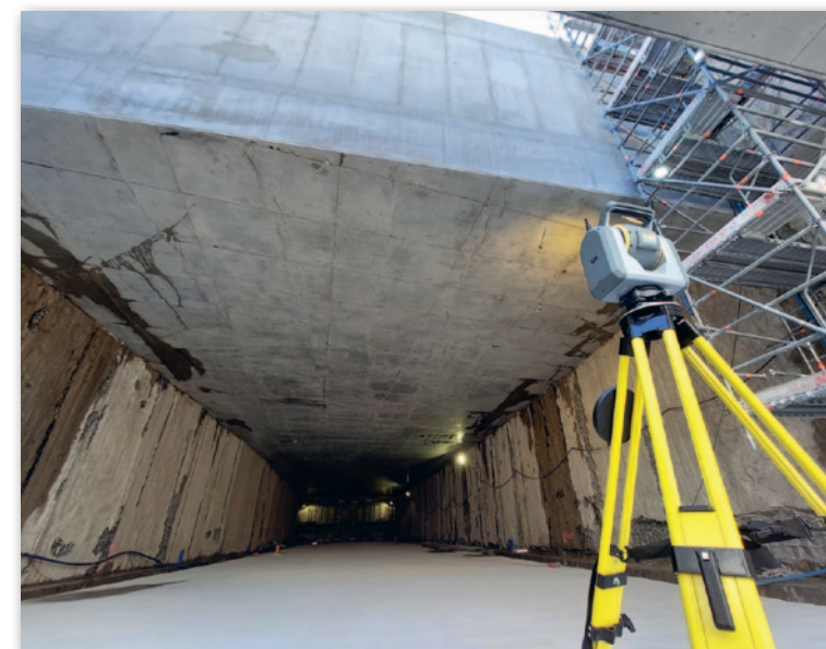
Skanowanie laserowe płyty dennej części rampowej tunelu
