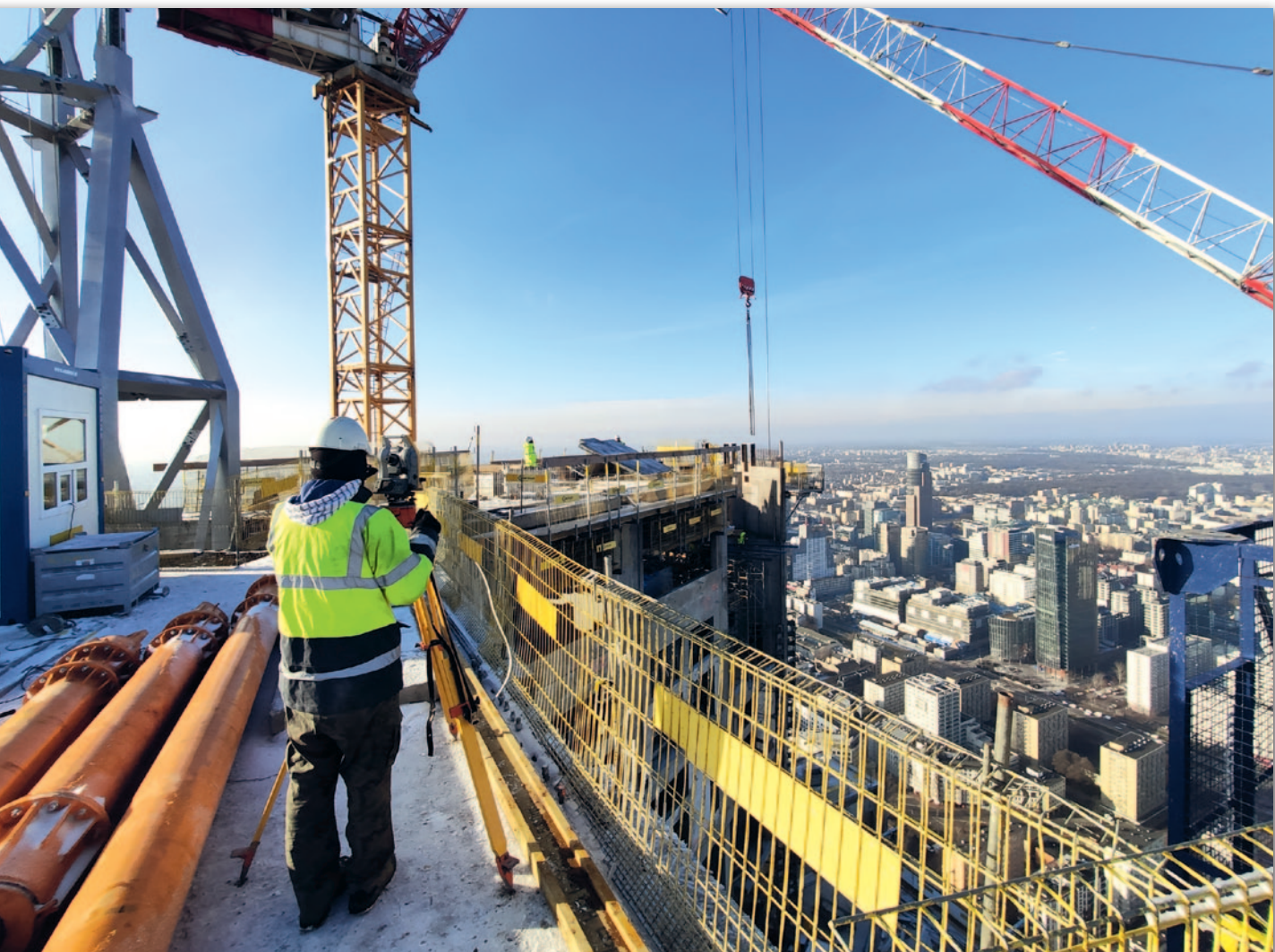
Tyczenie obrysu belki na 53. kondygnacji w styczniu br.
