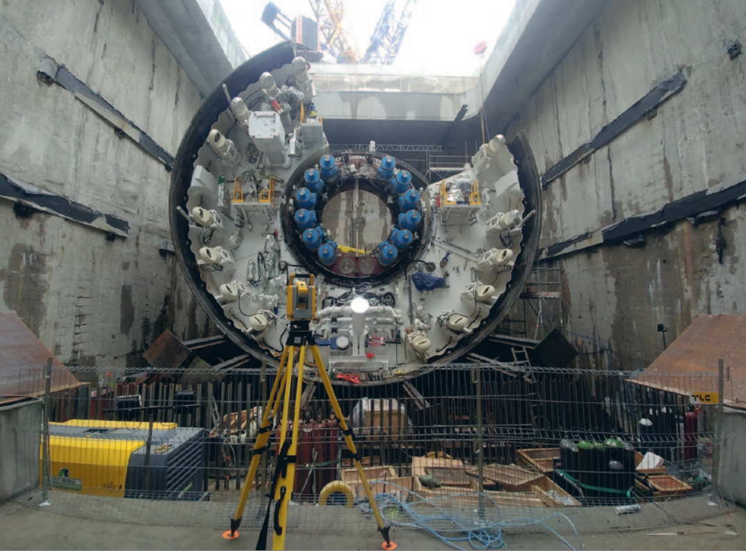
Kontrola montażu maszyny TBM w komorze startowej
