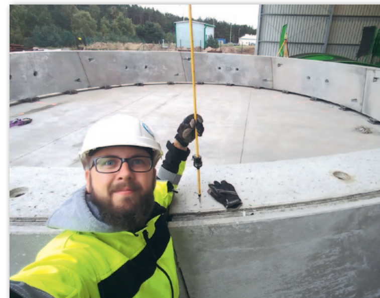
Kontrola próbnego montażu pierścienia obudowy tunelu
