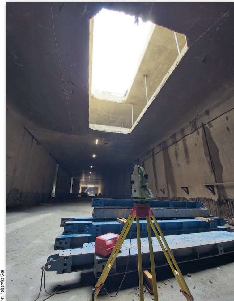
Prace w tunelu POW budowanym metodą podstropową
