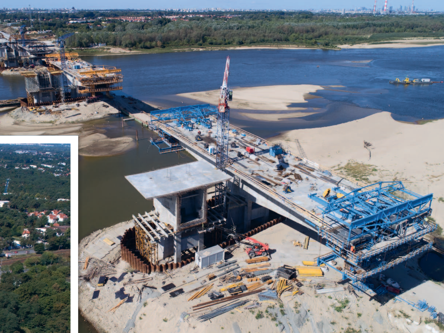
▲ Części najazdowe mostu budowane są metodą szalunków przejezdnych (MSS) | Side parts of the bridge are built using the movable scaffolding system (MSS)
