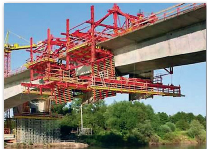
Fot. 4. Most realizowany metodą wspornikową – stan tuż przed zwróceniem konstrukcji
