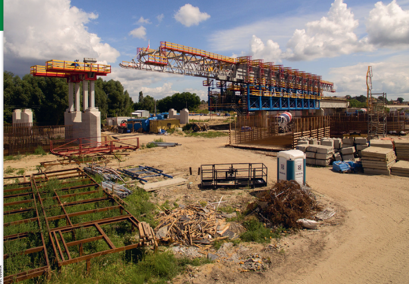
Fot. 3. Budowa części najazdowej mostu południowego przy użyciu szalunku MSS
