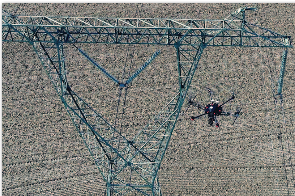
Inspekcja linii energetycznych z wykorzystaniem drona
