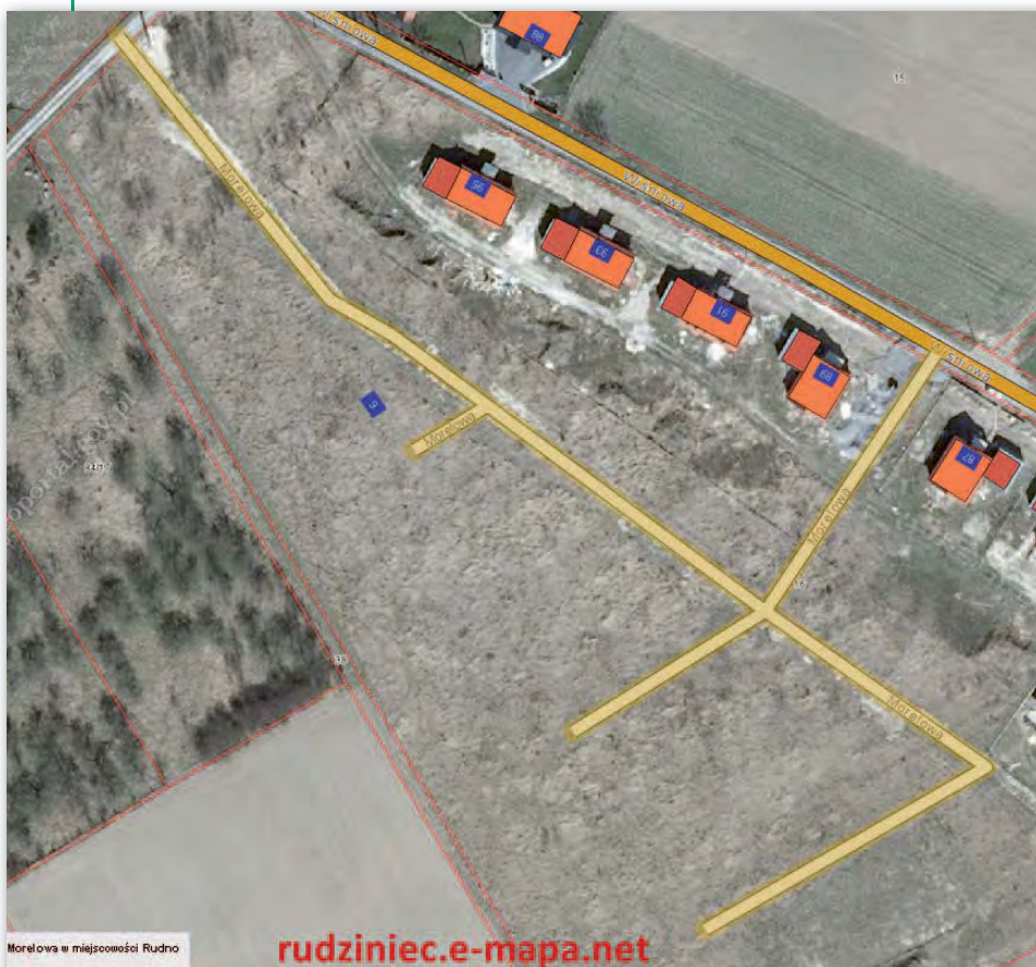
Rys. 2. Przykład ulicy, której geometrii nie można zapisać zgodnie z rozporządzeniem ws. EMUiA
