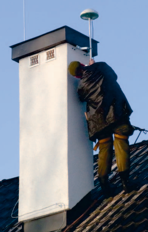
Montaż satelitarnej stacji referencyjnej na budynku biura budowy w Złoczewie
