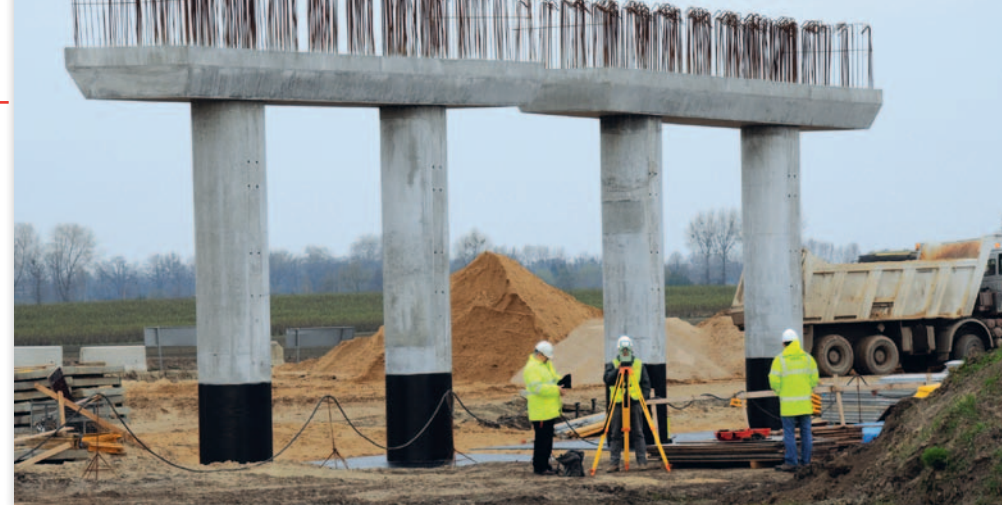
Przygotowania do nasuwania estakady na A1 między Toruniem a Nowymi Marzami. Po prawej: jeden z węzłów tej autostrady
