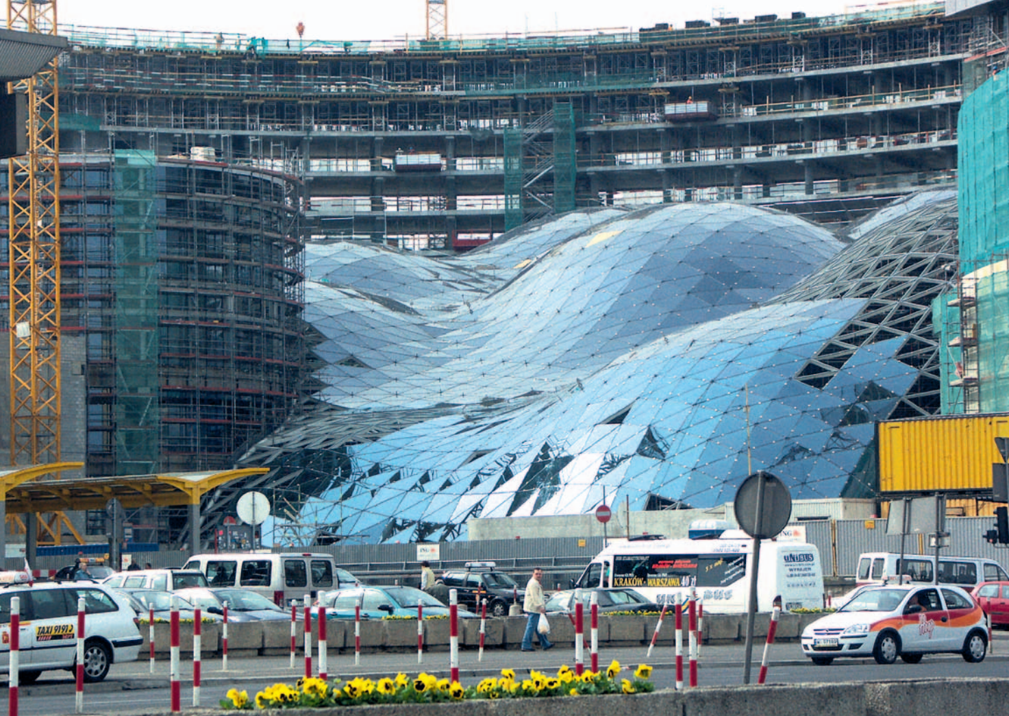
Złote Tarasy to kompleks handlowo-biurowo-rozrywkowy wybudowany w Warszawie latach 2002-07. Charakterystyczny pofalowany dach składa się z setek szklanych trójkątów, wśród których nie ma dwóch takich samych
