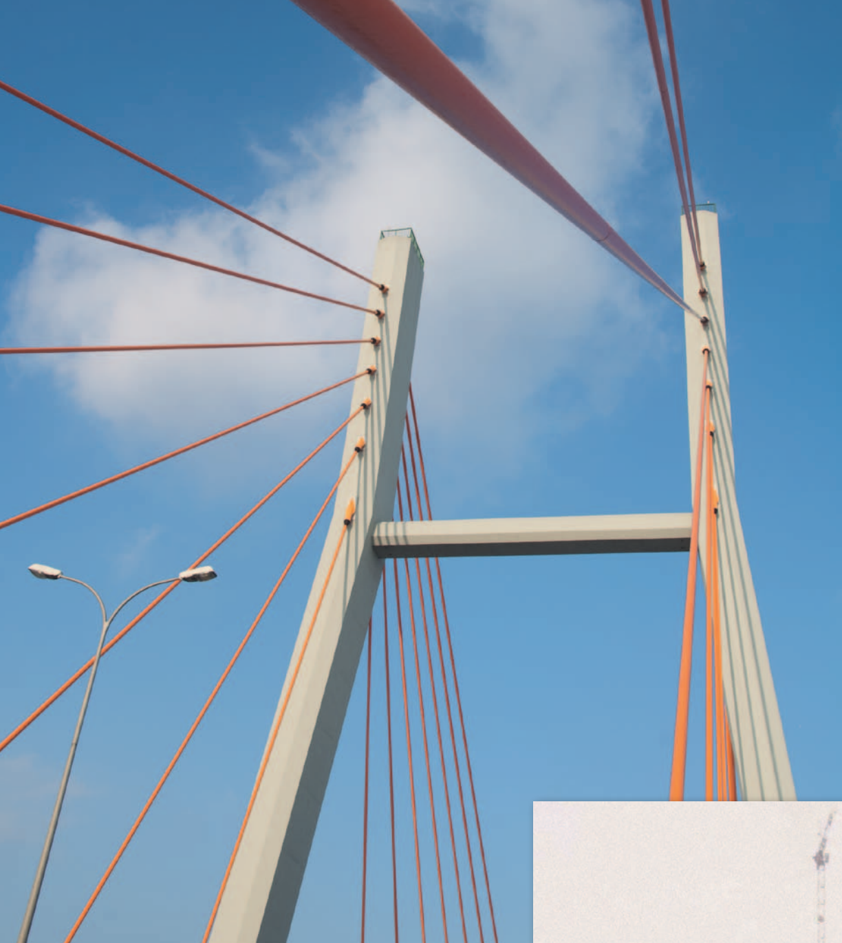
Most Siekierkowski łączący Mokotów z Pragą-Północ i Wawrem, budowany w latach 2000-02, wsparty na dwóch pylonach o wysokości 90 i 90,6 metra. W sumie 56 lin nośnych o łącznej długości 5300 metrów
