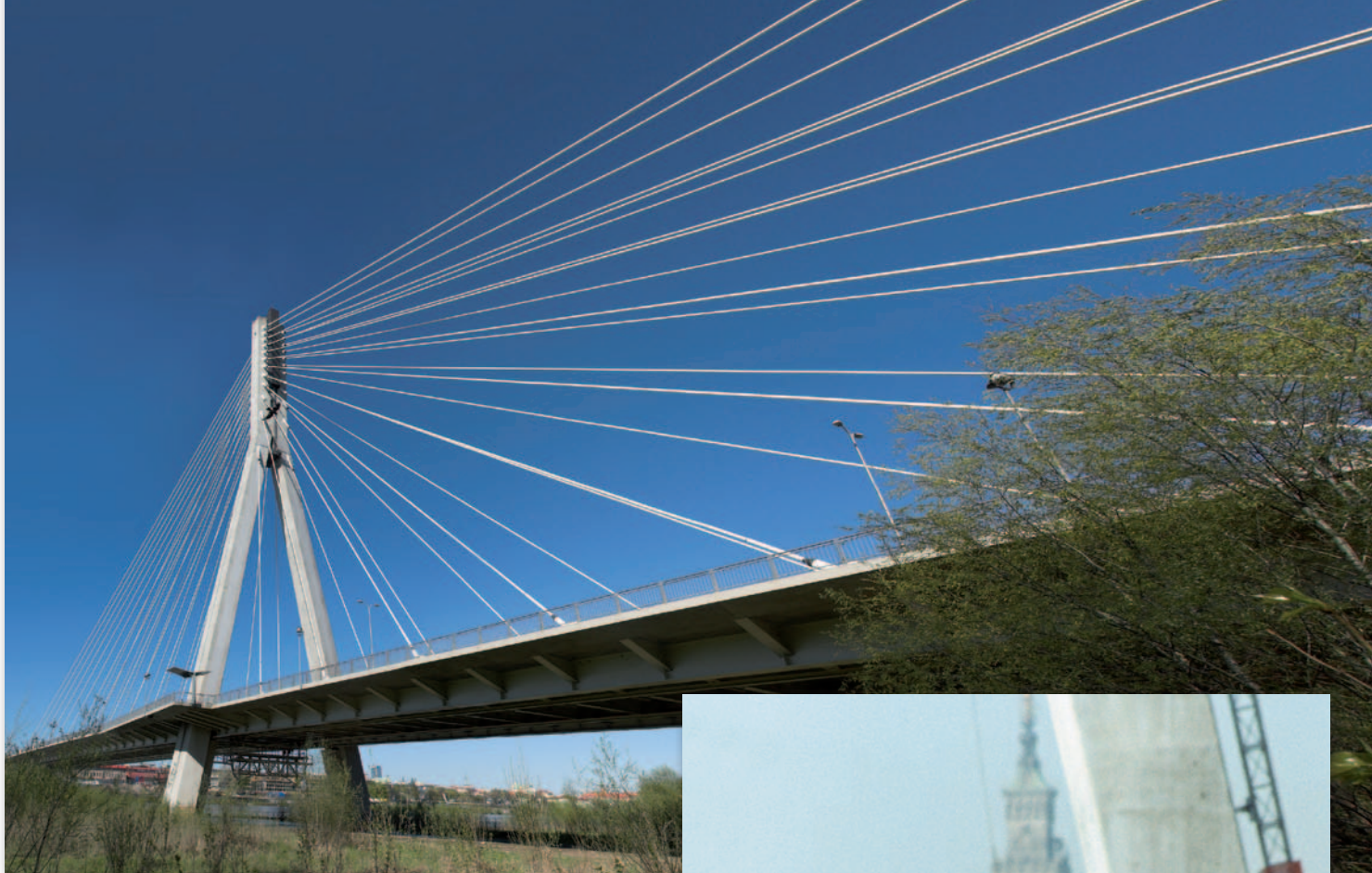
Most Świętokrzyski łączący Powiśle z Pragą-Północ, pierwszy podwieszony most na Wiśle, wybudowany w latach 1998-2000. Asymetryczna konstrukcja wsparta na jednym 90-metrowym pylonie, do którego zaczepiono 46 lin podtrzymujących przęsła
